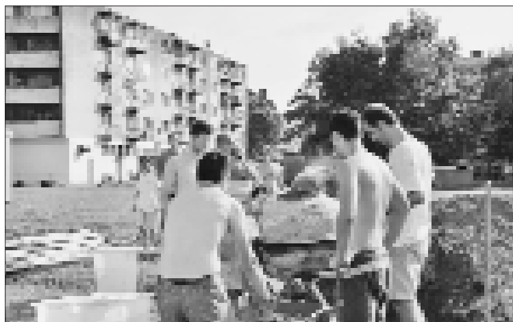
Volontari al lavoro nel cantiere della parrocchia di Bosanski Brod.
